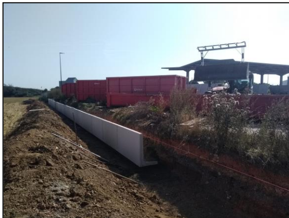
Vue sur l'espace derrière les bennes en cours des travaux
