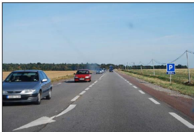
Sans aucune plantation d'accompagnement, les routes mettent peu en valeur le territoire traversé.
